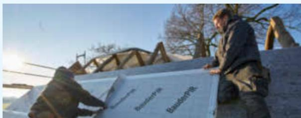
Bei der Aufsparrendämmung erhält das Dach eine geschlossene, wärmeschützende Haube aus leistungsstarkem Dämmmaterial.
